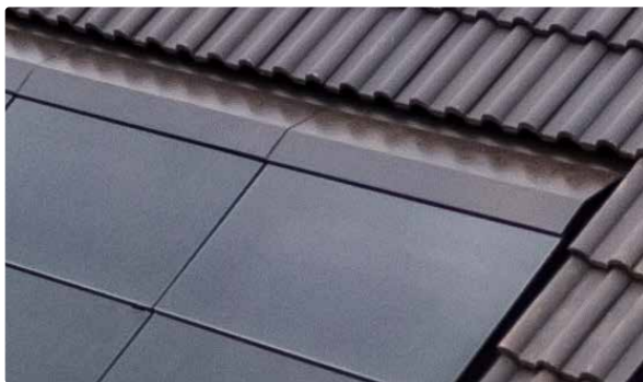
Overgang van pannen naar Navitect II
